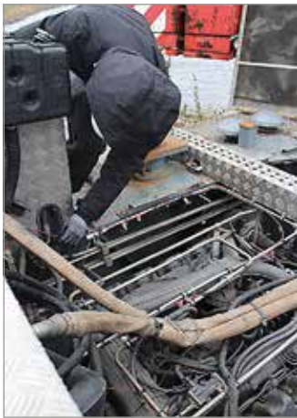
BussiPro Oy myy, asentaa ja huoltaa sekä Dafo- että Fogmaker-sammutusjärjestelmiä. Antti Rusasen mukaan toimintavarmiksi nähdyt järjestelmät vaativat kuitenkin säännöllistä tarkistusta toimintavarmuuden takaamiseksi.
